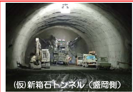
⑥施工：安藤・間
