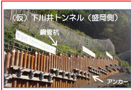
⑤施工：大成建設
