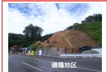
⑦施工：大成建設
