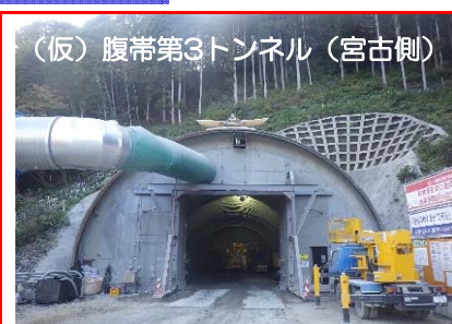
(仮)腹帯第3トンネル(宮古側) 9月中旬より第3トンネルの掘削を開始しました。現在約40m掘削が完了しています。岩盤が硬いため、昼夜で発破掘削をしています。
