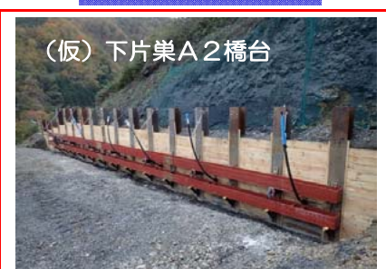
(仮)下片巣A2橋台 (仮)下片巣A2橋台を施工するため、山側に仮設土留を設置しています。
