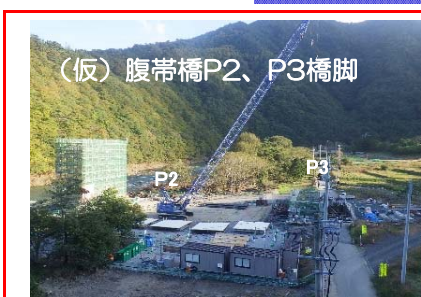
(仮)腹帯橋P2、P3橋脚 台風10号で被災しましたが、復旧作業が終わり、現在は本体工事を進めています。P2、P3ともに柱部の鉄筋組立、コンクリート打設をしています。
